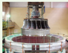
1号機水車ランナ吊り込みの様子
