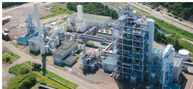
EAGLEパイロットプラント試験設備外観(若松研究所/福岡県北九州市)
