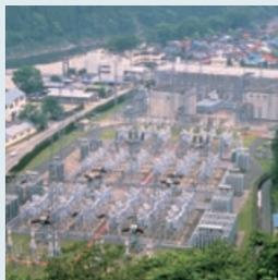
日本の電力の周波数は、明治時代に導入した発電技術の違いから、静岡県富士川を境に東側が50Hz、西側が60Hzと二分されています。佐久間周波数変換所は、二つの周波数を相互に変換することで予備電力を効率的に運用するために設けられた設備です。当社は昭和40年、当時スウェーデンで発達していた高圧直流送電技術を生かし、世界初となる30万kWの周波数変換所を完成させました。一方の交流をいったん直流にした後、さらに他方の交流に変換する方法で、50Hz/60Hzの両周波数系統を結んでいます。
