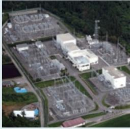
北本連系設備は昭和54年、日本初の直流超高圧送電線という新技術の導入により、北海道と本州の電力系統を結ぶ唯一の連系設備(送電能力60万kW)として運転を開始しました。両端にある交直変換所で交流から直流へ変換を行い、北本直流幹線により反対側の交直変換所へ送電した後、再度交流に変換することで、北海道・本州間の電力相互融通を行い電力の広域運営に貢献しています。
