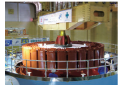
田子倉発電所(福島県南会津郡只見町)3号機更新工事
