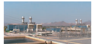
カエンコイ2ガス火力発電所(タイ国)
