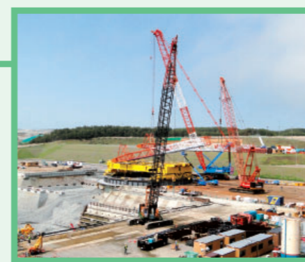
大型旋回式クレーン組立
