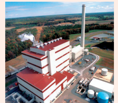
バーチウッド発電所 / 米国バージニア州 「全米有数のクリーンな石炭火力発電所」
