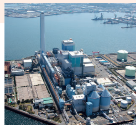
磯子火力発電所 / 神奈川県横浜市 (写真は平成21年4月時点)
