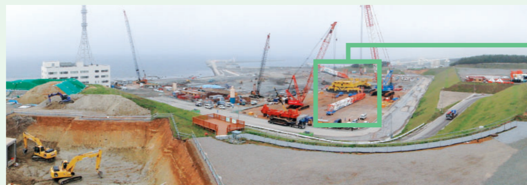
大間原子力発電所工事状況(写真は平成21年5月時点)
