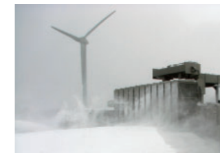
冬季の郡山布引高原風力発電所
