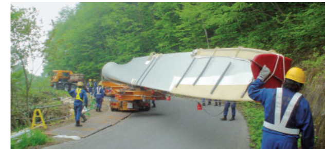
風力発電機設置の様子
