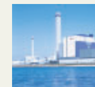
橘湾火力発電所
