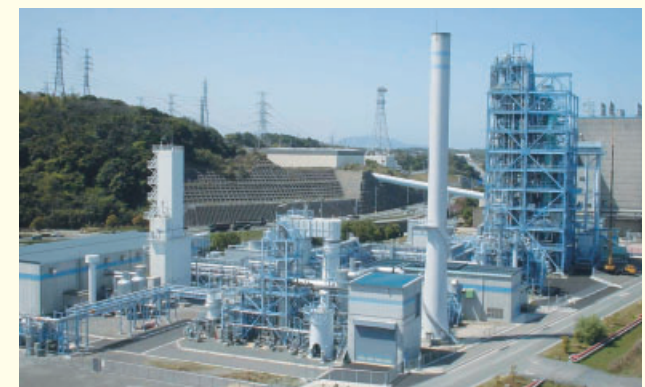
燃料電池用石炭ガス製造技術パイロットプラント
