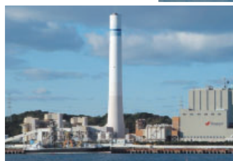
松島火力発電所
