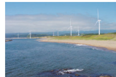
瀬棚臨海風力発電所
