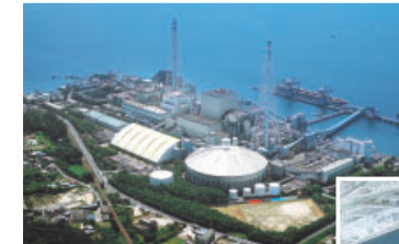
竹原火力発電所（広島県）
