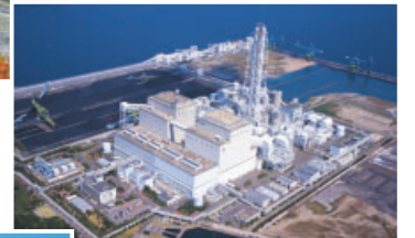
松浦火力発電所（長崎県）
