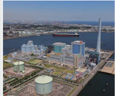
磯子火力発電所（神奈川県）
