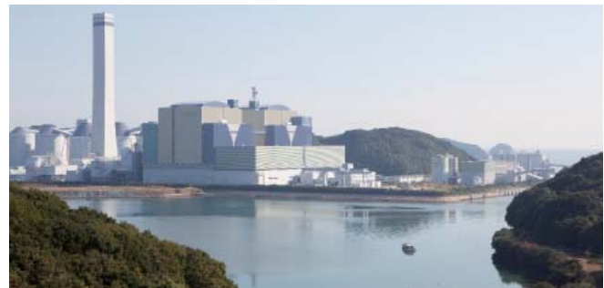
橘湾火力発電所 (徳島県)
