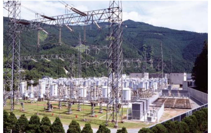
佐久間周波数変電所
