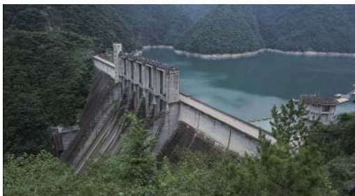
佐久間発電所 (静岡県)
