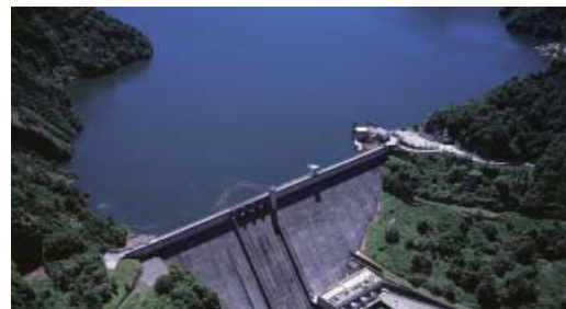
田子倉発電所 (福島県)
