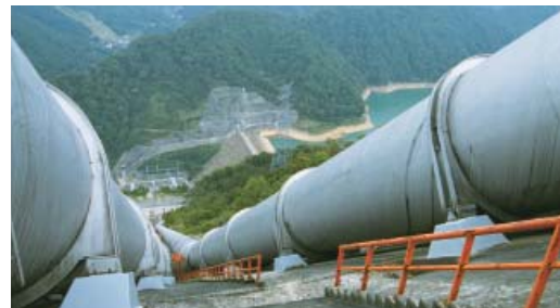
奥清津発電所 (新潟県)
