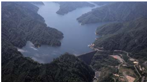
奥只見発電所 (福島県)
