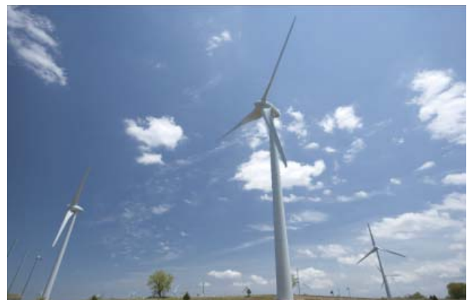
郡山布引高原風力発電所(福島県)
