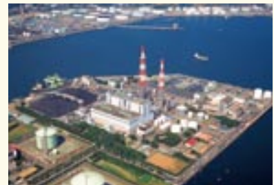
磯子火力発電所 (リブレース前)
