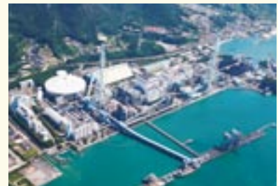
竹原火力発電所 (広島県)
