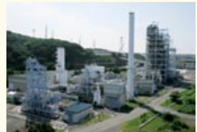
EAGLEパイロット試験設備（福岡県）
