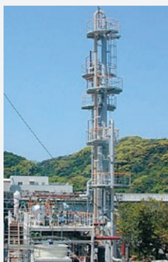
松島火力発電所2号機におけるCO 2 分離回収実証試験設備
