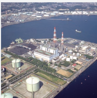
磯子火力発電所：1967年運転開始
