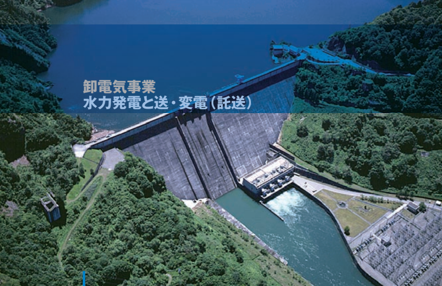
田子倉発電所（福島県）
