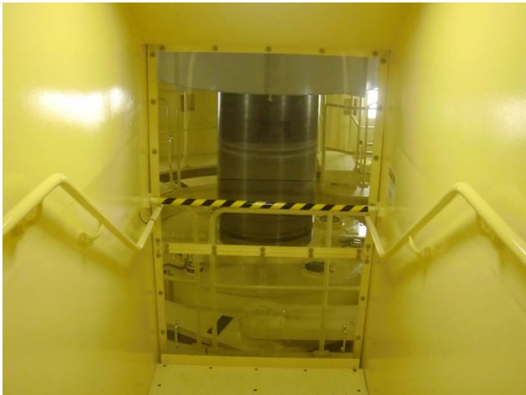
○発電機と水車をつなぐ太い軸も見学します。高速回転しているね!
