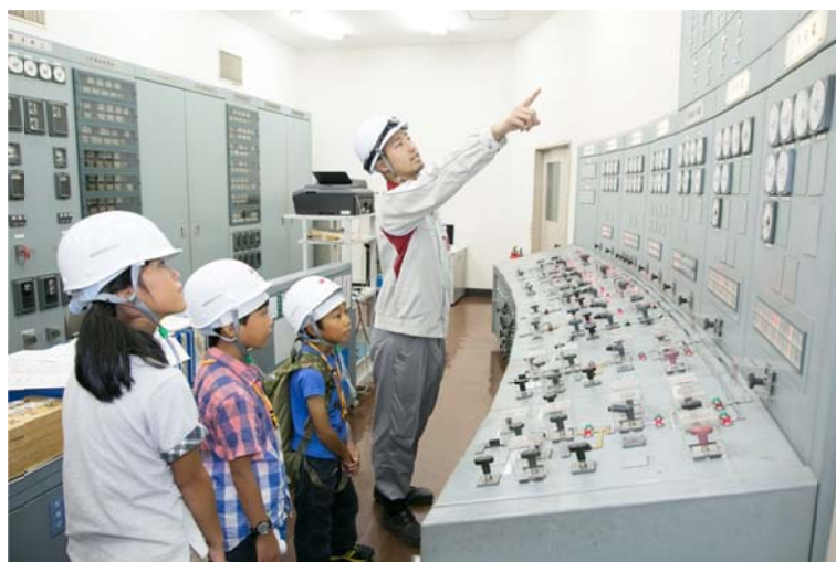
○旧配電盤室。昔はこの部屋で発電所の運転を制御していました。
