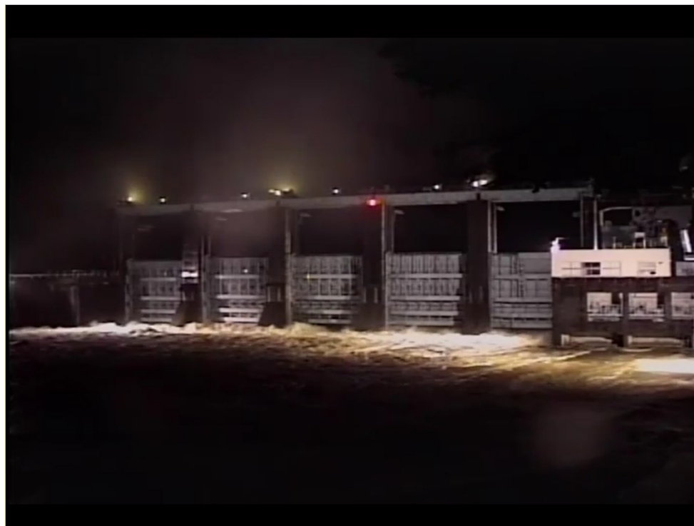
瀬戸石ダム通砂／排砂運用中状況(7月14日00時00分、3, 200m 3 ／秒 放流状況)
