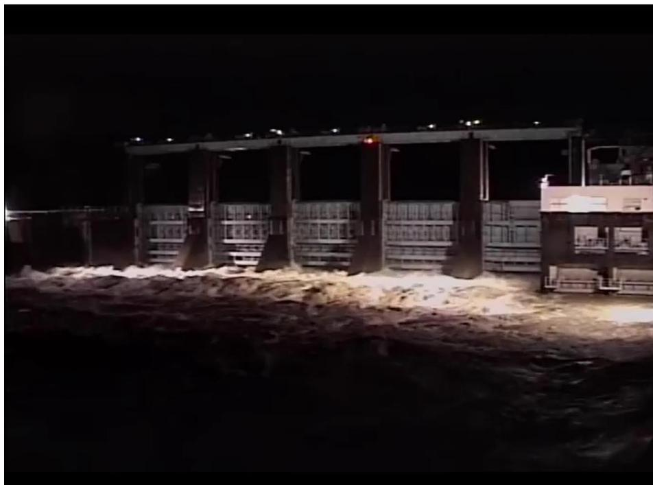
瀬戸石ダム通砂／排砂運用中状況(7月3日21時30分、2,085m<sup>3</sup>/秒 放流状況)
