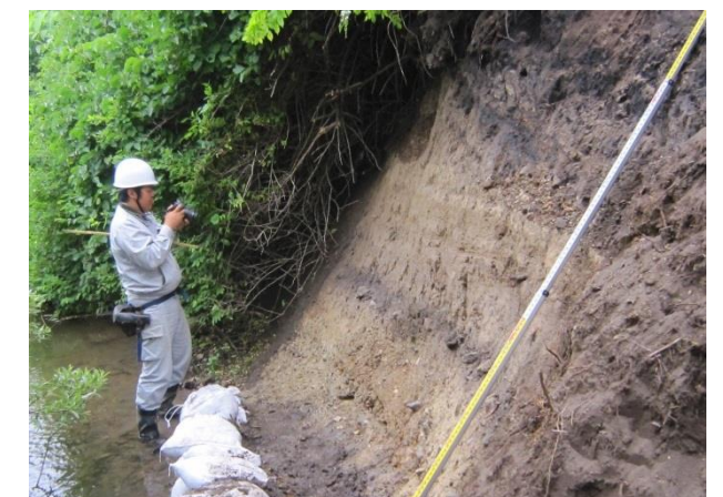
図6 法面観察作業状況(事例)
