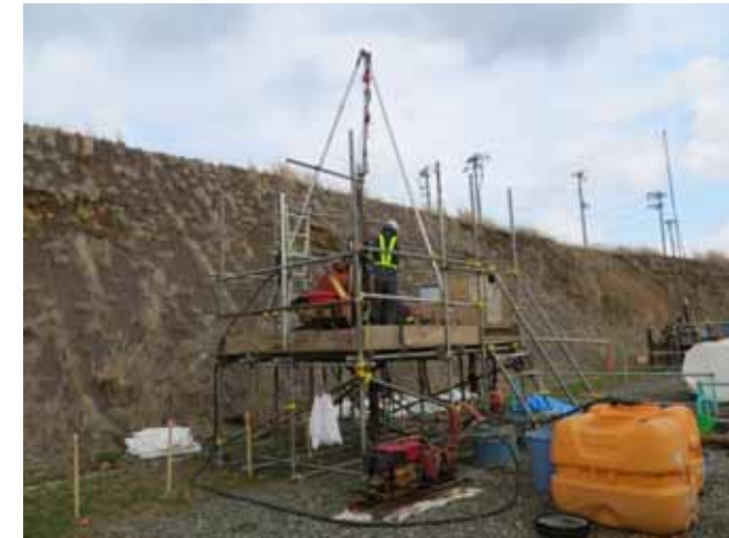
図2 ボーリング調査作業状況(事例)
