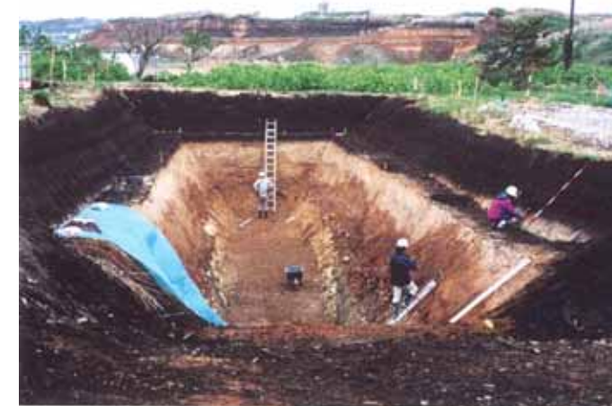
図4 トレンチ調査作業状況(事例)
