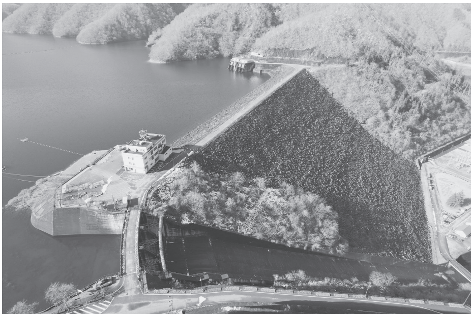
巨大なロックフィル式の九頭竜ダム。ダム堤左岸地下に長野発電所がある
