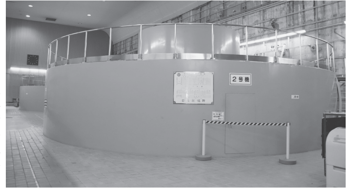
長野発電所2号機。巨大なダムだけでなく地下にも巨大な空間が広がる
