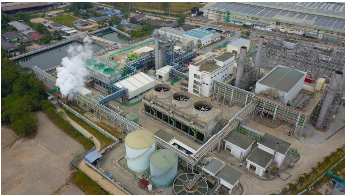
エグコ・コジェン ガスコジェネレーション発電所
