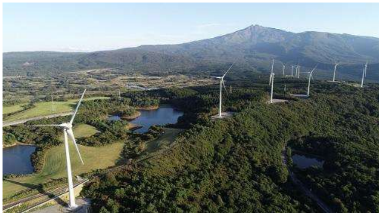
プロジェクト例-2 WE-02 にかほ第二風力発電所(秋田県 41.4MW 2.3MW×18基)
