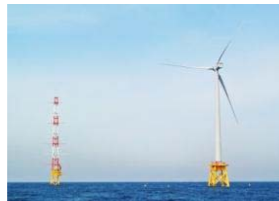
洋上風力発電システム実証研究
