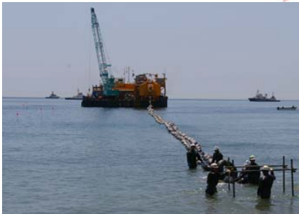
北本直流幹線 新設ケーブル(2012年 12月使用開始)の布設 作業
