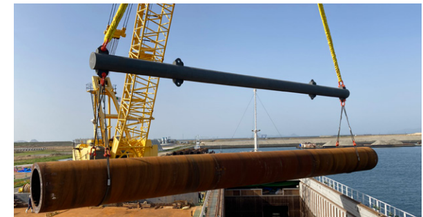
風車の基礎となる杭の搬入
