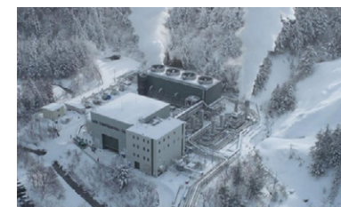
鬼首地熱発電所
