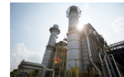
カエンコイ2ガス火力発電所(タイ)
