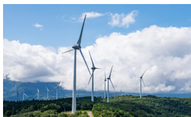
にかほ第二風力発電所
