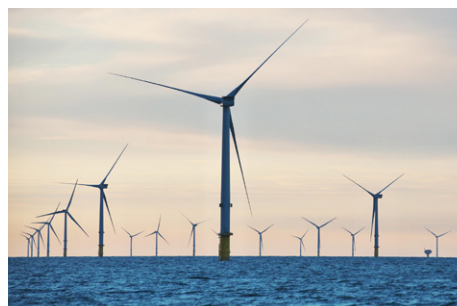
トライトン・ノール洋上風力発電所(英国)
