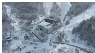
鬼首地熱発電所
