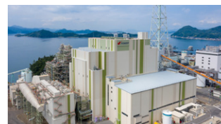
竹原火力発電所新1号機
