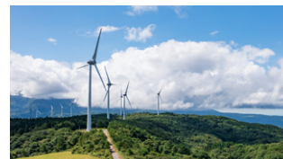
にかほ第二風力発電所
