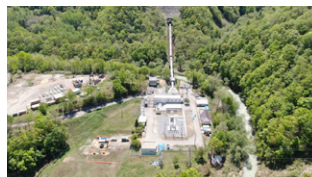
新桂沢発電所
