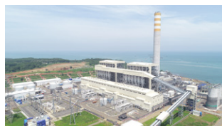
バタン発電所(インドネシア国) 写真提供: PT ピマセナ パワー インドネシア
