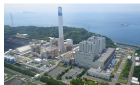
松島火力発電所(1981年商業運転開始)
