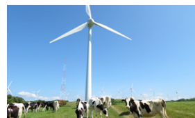
苫前ウインドビラ(2000年商業運転開始) ※更新工事中
