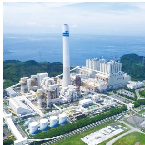
現在の松島火力発電所
