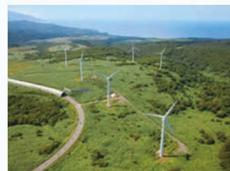
鳥牧ウインドファーム (2021年5月リプレース工事着工)
