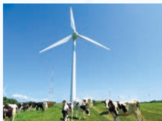
苫前ウィンピラ発電所 (2020年8月リプレース工事着工)
