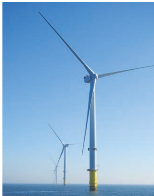
トライトン・ノール洋上風力発電所 (英国、建設中)
