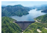
奥只見発電所(福島県)
