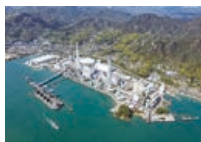
竹原火力発電所(広島県)
