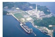
③ 松島火力発電所運転開始
