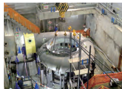
新桂沢発電所建設工事の様子
