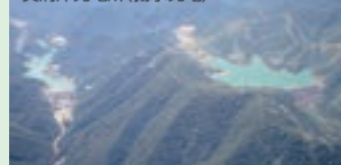
奥清津発電所(揚水発電)
