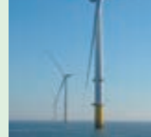
トライトン・ノール洋上風力発電所(イギリス)
