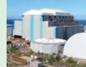
大間原子力発電所(建設中)
