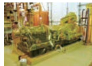
ポンプを養生するためのビニールはオレンジ色のものを使用
