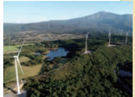
にかほ第二風力発電所
