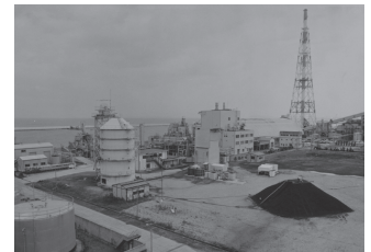
若松火力発電所
