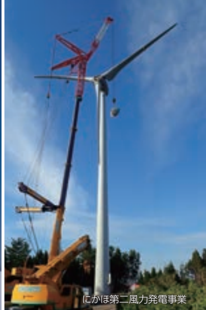
苫前ウィンピラ発電所
