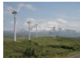
仁賀保高原風力発電所(秋田県)
