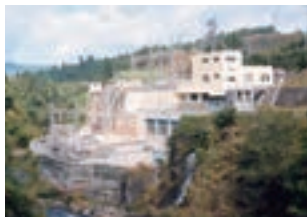
黒又川第一発電所
