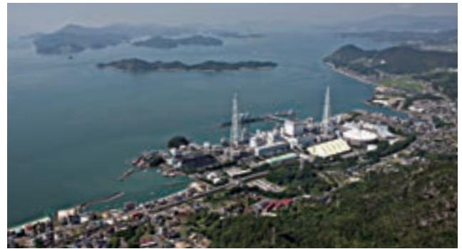
新1号機の建設が進む竹原火力発電所
