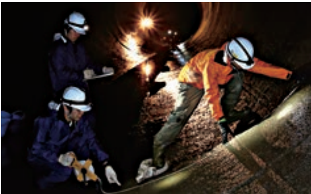
水力発電所の保守現場
