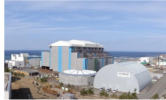
建設中の大間原子力発電所（青森県）
