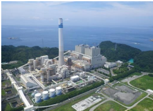
現在の松島火力発電所（長崎県）
