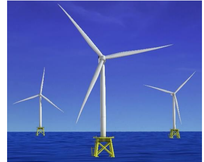
福岡県 北九州響灘洋上 ウインドファーム(建設中)
