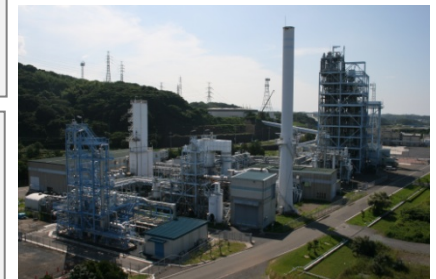
EAGLEパイロット試験設備(福岡県)
