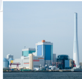
磯子火力発電所 (神奈川県)
