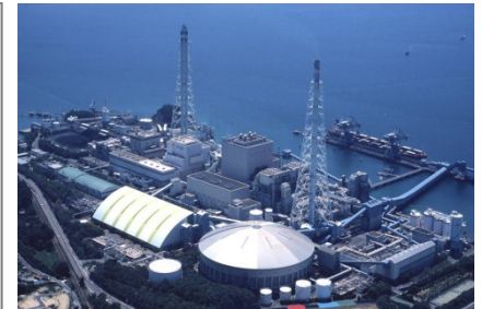
竹原火力発電所(広島県)
