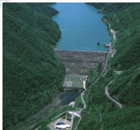
御母衣発電所(岐阜県)
