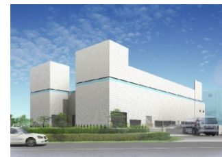
下水汚泥燃料化施設(広島県)
