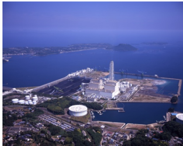
松浦火力発電所(長崎県)
