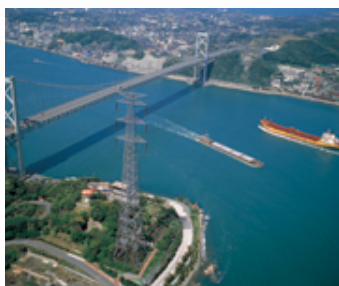
関門連系送電線 (山口県・福岡県間)
