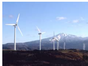
仁賀保高原風力発電所(秋田県)
