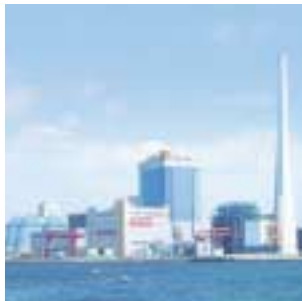
リブレース工事を終えた磯子火力発電所新1号機が2002年4月から営業運転を開始しました。新2号機の建設も予定しています。(2009年7月運転開始予定)
