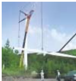
グリーンパワーくずまき風力発電所風車据付工事
