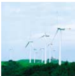
仁賀保高原風力発電所(24,750kW)は国内有数の大規模ウィンドファームです。また新たな建設適地の開発に向けて数多くの風況調査を実施しています。
