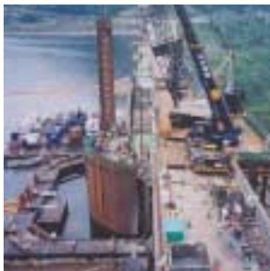
奥只見発電所増設工事では、大水深用仮締切工法の開発などにより、水位制約を行うことなく20万kWの出力増加に成功しました。
