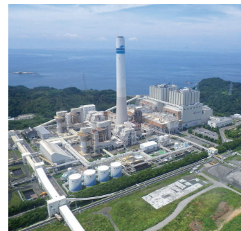
松島火力発電所 (100万kW・長崎県)
