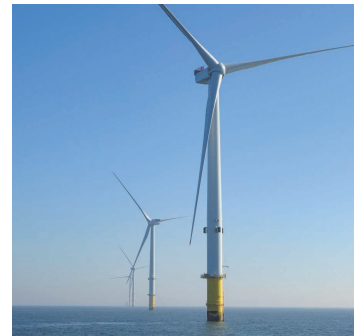
トライトン・ノール洋上風力 (85.7万kW・イギリス)
