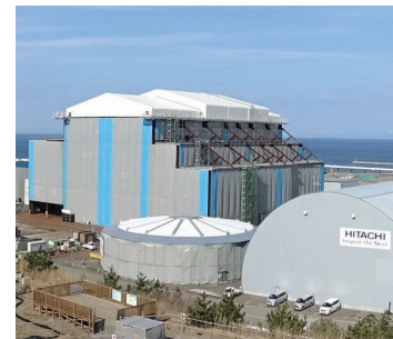
大間原子力発電所の建設状況
