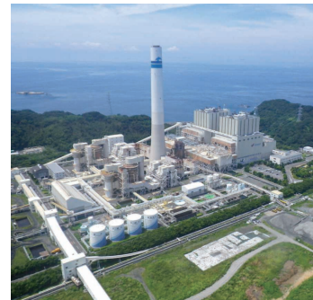
松島火力発電所 (100万kW・長崎県)
