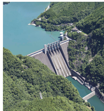
佐久間ダム・発電所 (35万kW・静岡県)
