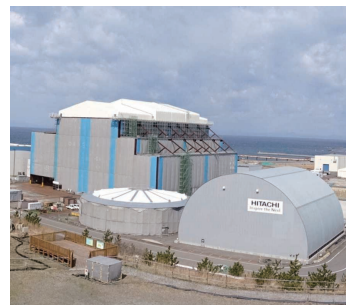
大間原子力発電所の建設状況
