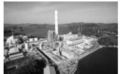
大崎クールジェン（酸素吹IGCC実証試験発電所）
