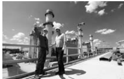
グリーン・カントリー発電所
