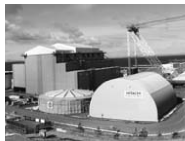
大間原子力発電所の建設状況（平成29年3月現在）
