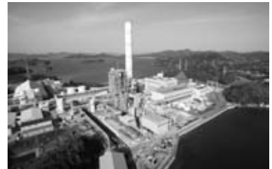
大崎クールジェン（酸素吹IGCC実証試験発電所）
