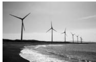
由利本荘海岸風力発電所
