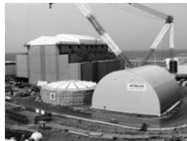
大間原子力発電所の建設状況（平成27年3月現在）
