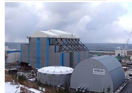
建設状況（2023年12月末時点）
