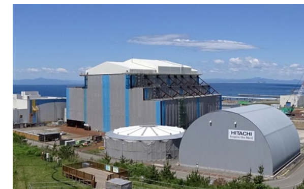
建設状況（2023年6月末時点）
