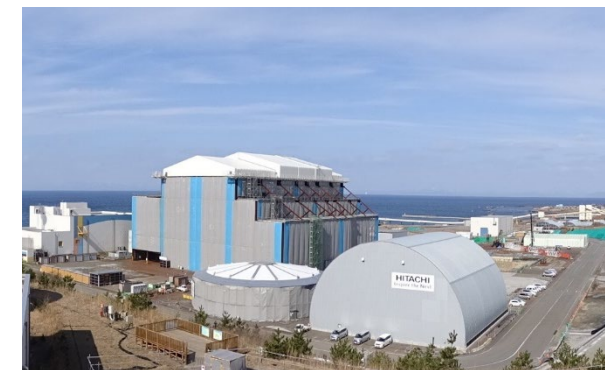
建設状況（2023年3月末時点）
