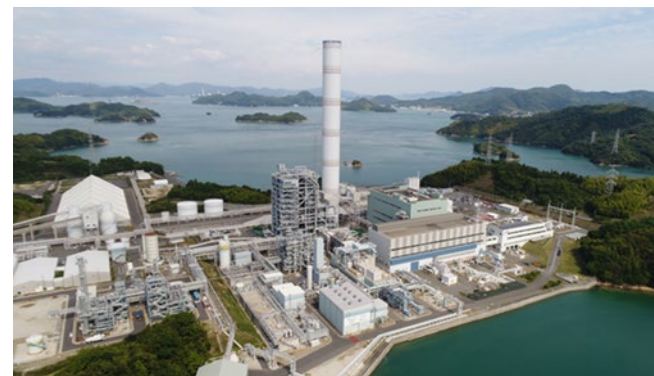
燃料電池設備 固体酸化物形燃料電池(SOFC) 発電出力：1.2MW級 (0.6MW級モジュール×2基)
