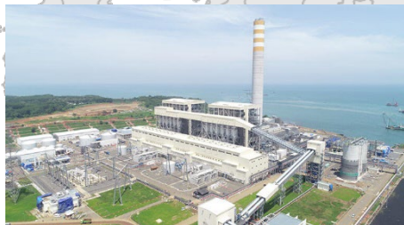
バタン発電所
