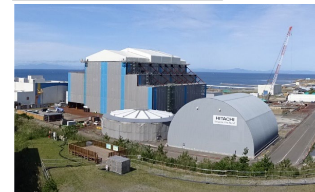
建設状況（2022年9月末時点）
