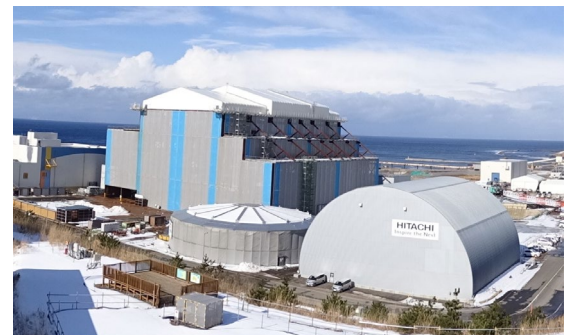
建設状況 (2022年3月末時点)
